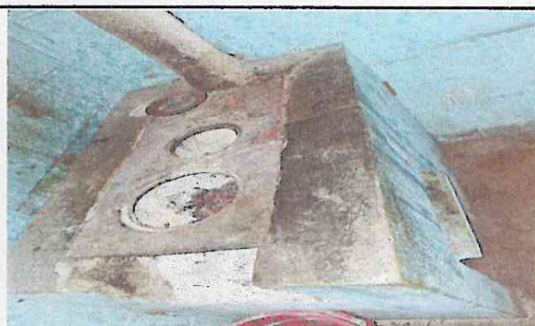
Foto 4: Sustitucion de plancha de metal de 3 hornillas e instalación de azulejos.
