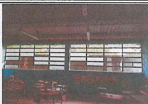
Foto 2: Sustitucion de vidrios y balcones
