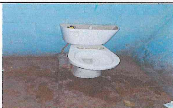
Foto 5: Sustitución de sanitario y sus accesorios
